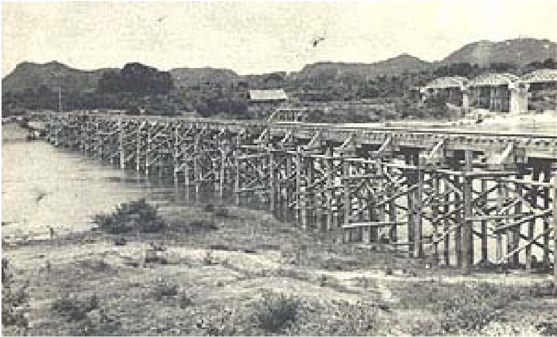
タマルカン(タイ)に近いメクロン川沿いの木材仮設橋。
